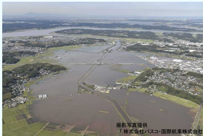
浸水被害（佐倉市）
