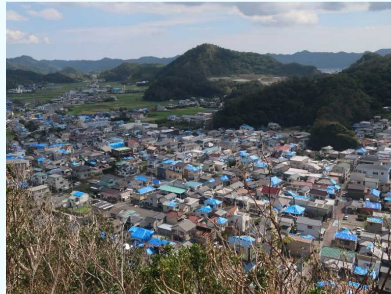
多くの住家の屋根をブルーシートが覆っている様子（鋸南町）
